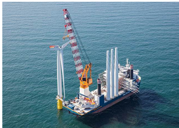
De laatste windturbine werd afgelopen zomer geplaatst
